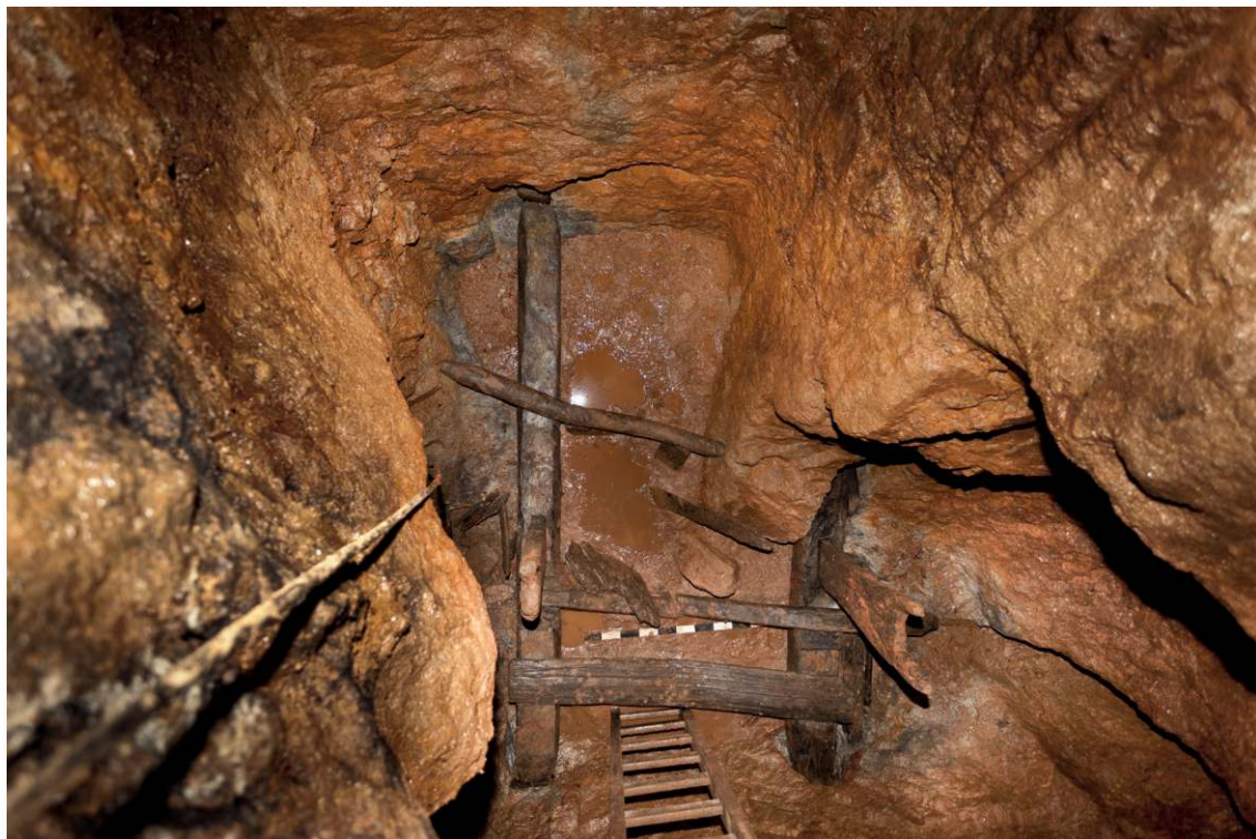
Obr. 104 Tento hašpl byl nalezen na původním místě v jednom ze středověkých dolů v Dippoldiswalde.
