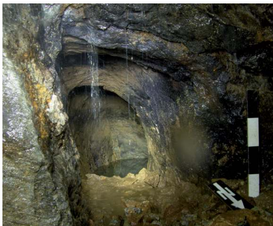
Obr. 43 Sázení ohně zanechává vejcovitý průřez chodeb, jak tomu bylo nejspíš i v tomto případě z Niederpöbelu.
