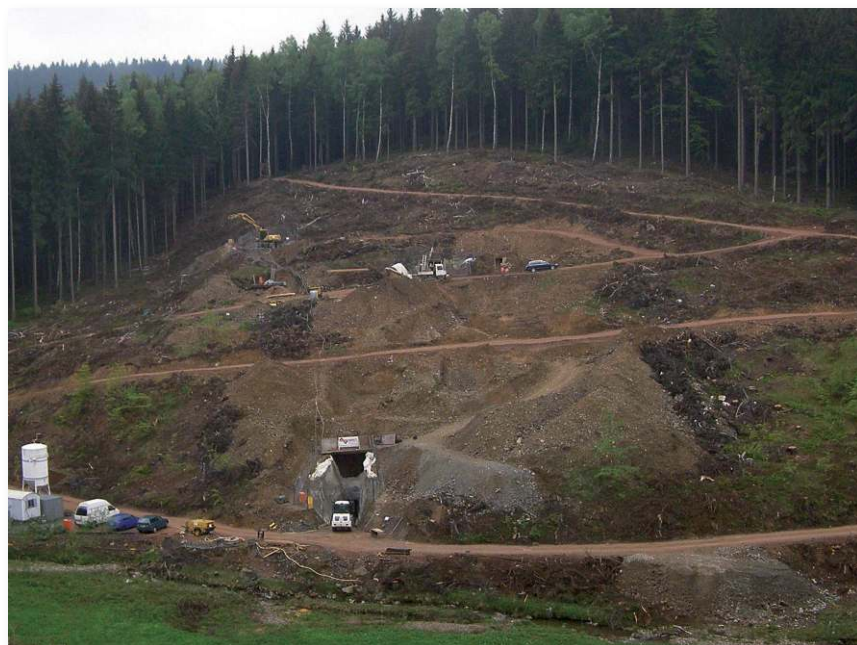
Obr. 49 Během stavby protipovodňové přehrady na západním svahu údolí říčky Pöbel v Niederpöbelu mohly být Zemským úřadem pro archeologii Sasko v úplnosti prozkoumány a dokumentovány středověké doly.
